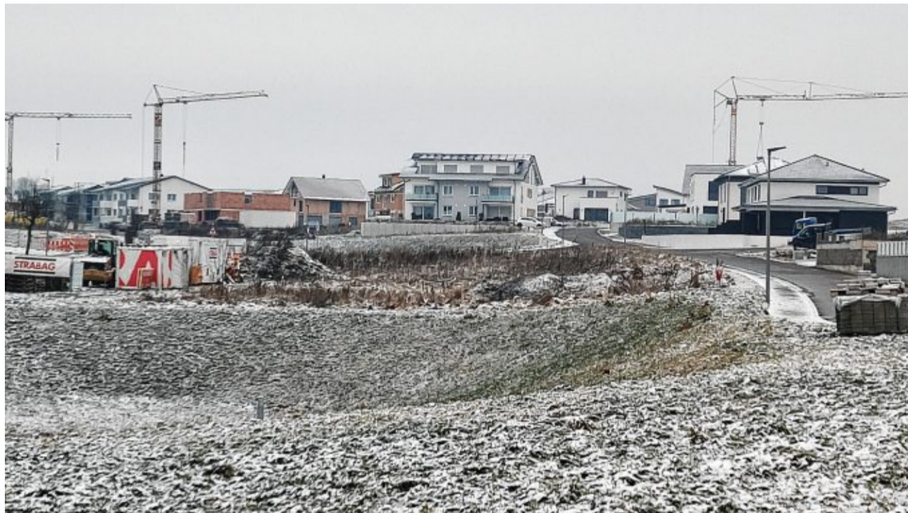
Gebaut wird derzeit in der Stadt Pfullendorf immer noch sehr viel. Doch sind diese Häuser auch für ein zukünftiges Seniorenwohnen geeignet? Auch darüber wurde diskutiert. Bemängelt wurde eine fehlende Infrastruktur. Für Besorgungen braucht man ein Auto oder den Bürgerbus. BILD: KARLHEINZ FAHLBUSCH
